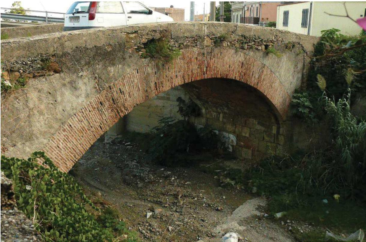
Figura 16. Il ponte Schiavo con in evidenza la fondazione a grossi blocchi ben squadriati.
