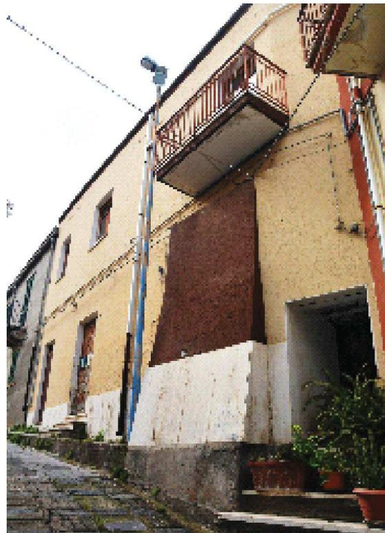
**Figura 3. Visione esterna della torre di Furnari, priva di qualsiasi segno distintivo riconducibile ad un manufatto medievale. Si noti il contrafforte appoggiato all'esterno della torre, accanto alla nuova apertura, dove il muro conserva una piccola porzione di forma pressoché circolare, come all'interno.**
